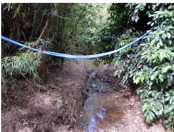
Foto 17: Vista da calha do córrego Soberbo. – 16/11/16
