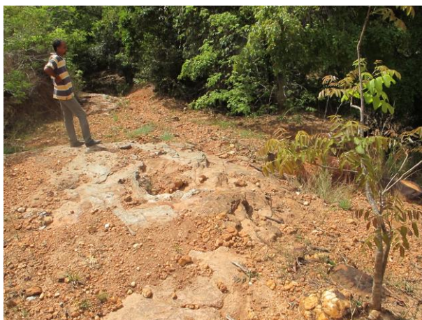
Foto 6: Local com declividade acentuada e erosão nas margens do Córrego dos Queijos. – 16/10/16
