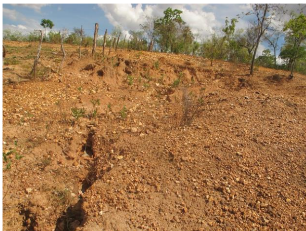
Foto 4: Vista da erosão em sulco na Micro Bacia do Córrego do Engenho. – 15/10/16
